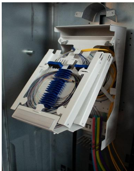
Bild. Exempel på svetsade splitter i markskåp
