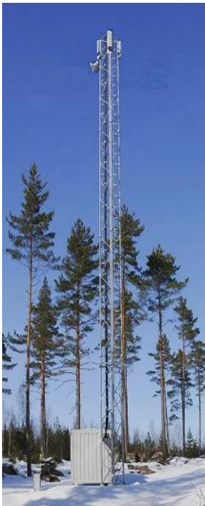
Antennbärartyp: 3-sidigt fackverkstorn Ostagat
