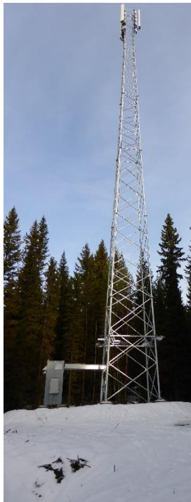
Antennbärartyp: 4-sidigt fackverkstorn Ostagat
