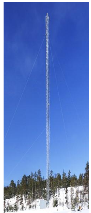
Antennbärartyp: 3-sidigt fackverksmast Stagad
