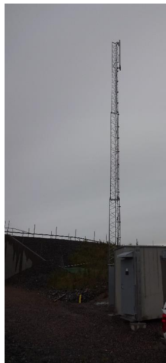
Antennbärartyp: 3-sidigt fackverkstorn Ostagat
