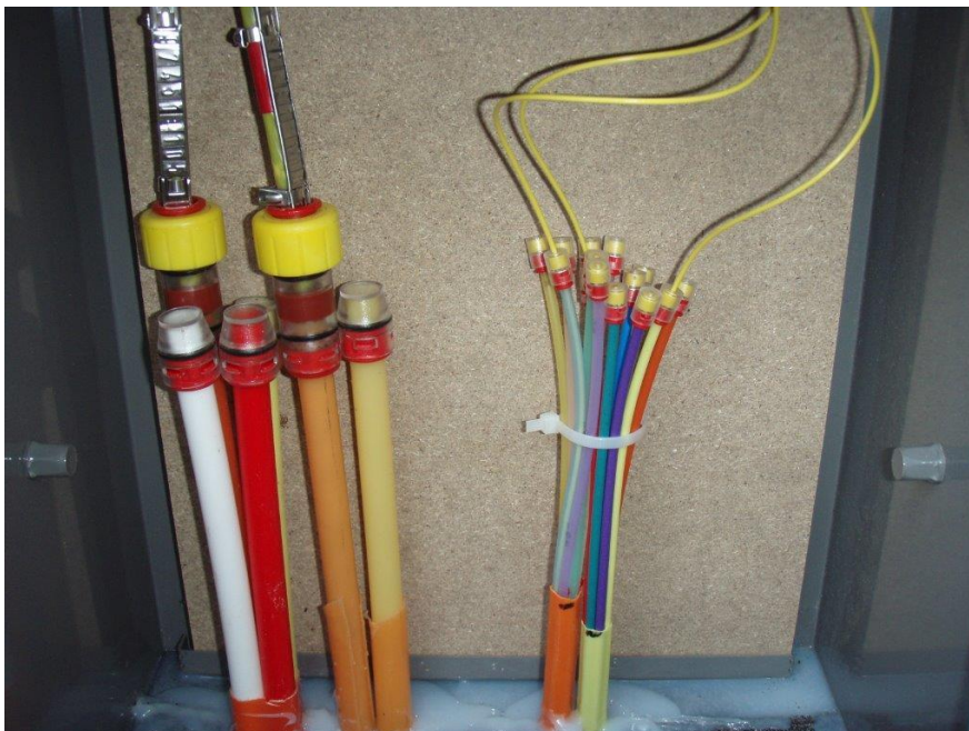
Bild – Korrekt tätning av fiberkanalisation
